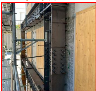
▲ 鉄骨の施工
