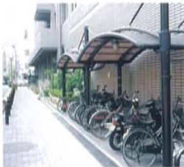
阿波座センタービル
