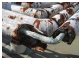
配管断熱材の損傷
