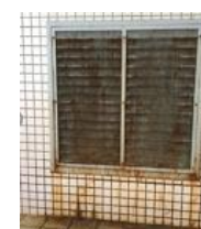
吸入口の腐食
