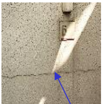
仕上げ材のひび割れ
