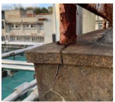
支柱部付近の損傷
