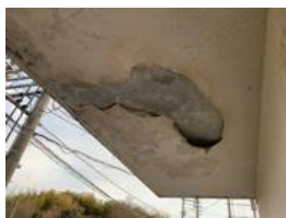
底部の仕上げ材の剥れ
