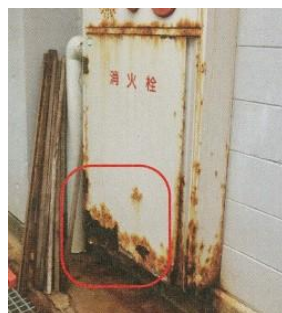
消火栓箱の損傷♦10
