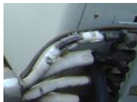
配管断熱材の剥れ
