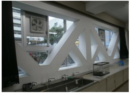
ブレース設置（窓面）
