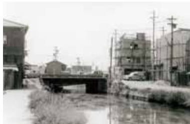
西三荘用水路横堤橋付近(昭和29年頃)
