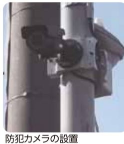
防犯カメラの設置
