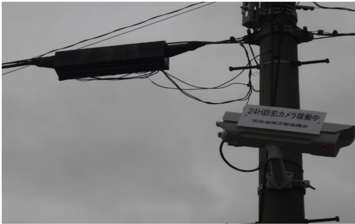
防犯カメラ 設置数:30台
