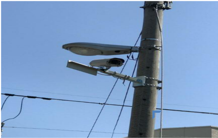
防犯カメラ 24台設置
