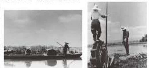
パーチカル(エンジンの駆動で水を吸い上げるもの。船尾に搭載)を積んで田んぼに水を入れていた。パーチカルが使えない所は、水車で水を入れていた。
