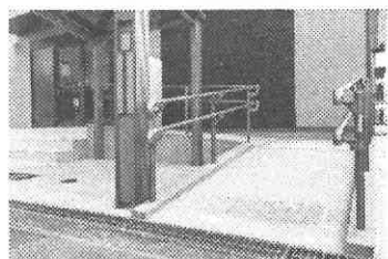
歩道から玄関へのスロープ
