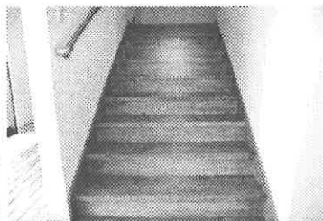
2階への階段（手すり付き）
