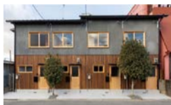
改修イメージ(改修前→改修後)
