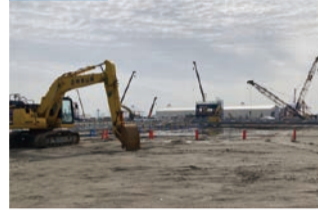
建築工事の様子
