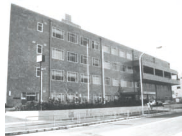
完成した鶴見区役所庁舎(昭和49年)
