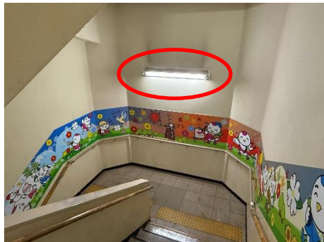
1階から地下1階への踊り場に蛍光灯が1つ設置されているため、それをLED電灯に付け替える
