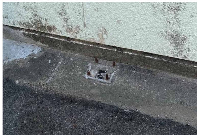
拡大写真(右側の固定ねじが1本外れている)
