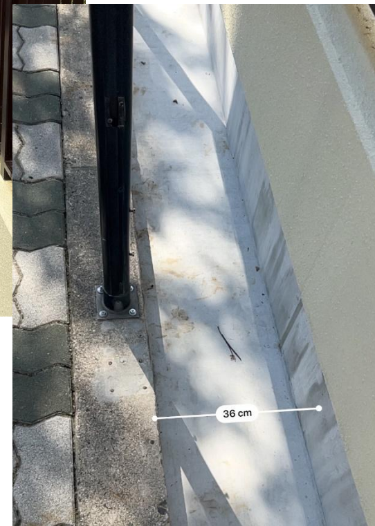
側溝の幅(約36cm)
