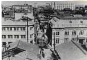
拡張前(幅6m)の淀屋橋筋 (現御堂筋)
