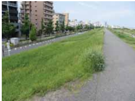
堤防の裏のり面
