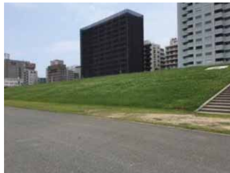
堤防の表のり面
