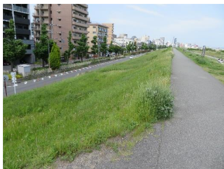
堤防の裏のり面
