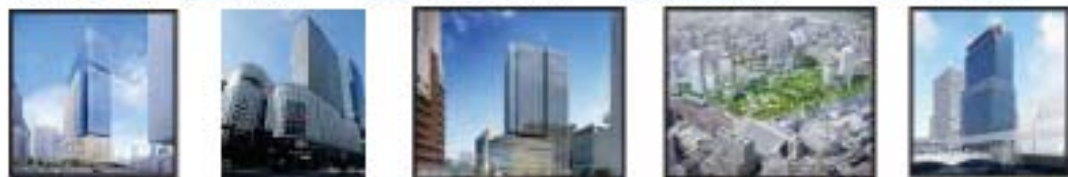
⑥大阪駅南地区 (梅田3丁目計画) ⑦大阪駅南地区 (三井不動産タワー) ⑧梅田一丁目地区 (三井不動産インテックス・オックス) ⑨うめきた2期中央地区 ⑩堂島浜一丁目地区
