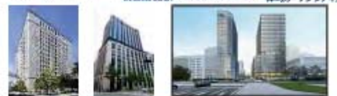
⑯今橋三丁目地区 (日本生命本町ビル) ⑰伏見町三丁目地区 (三井UFJ銀行大阪ビル) ⑱東区橋筋地区 (右) ⑲東区橋筋地区 (左)
