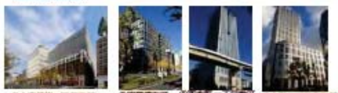
⑫心斎橋筋一丁目地区 (御堂筋ビル) ⑬東区橋筋地区 (御堂筋ビル) ⑭西本町一丁目地区 (オリックス本町ビル) ⑮本町三丁目地区 (本町ガーデンシティ)
