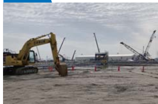
建築工事の様子
