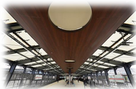
改装された OsakaMetro新大阪駅 出所：区広報誌「よどマガ！」
