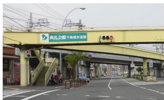
千鳥橋歩道橋
