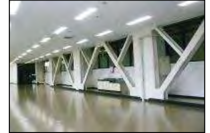
耐震改修工事の実施事例
