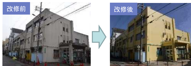
市設建築物の長寿命化事例(外壁改修)
