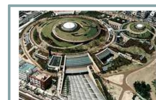
計画的な維持管理と安全確保のための大規模改修 中央体育館(~R7)
