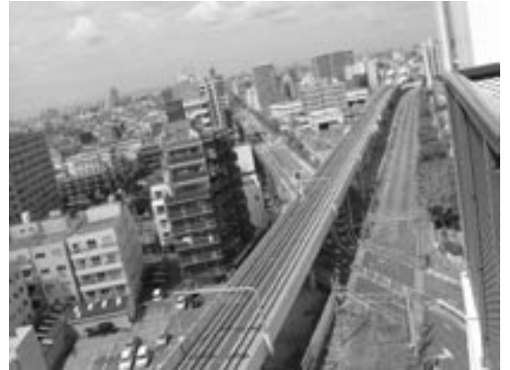
JR阪和線連続立体交差事業(あびこ筋)
