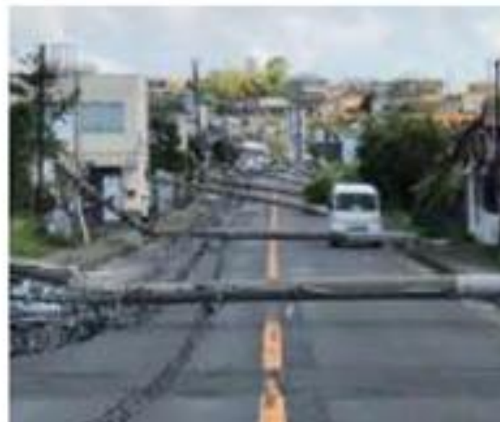
（大阪市無電柱化推進計画より）
