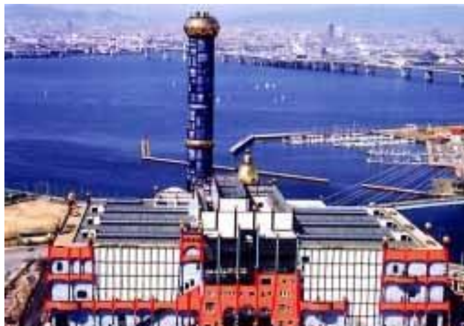
■舞洲スラッジセンター外観
