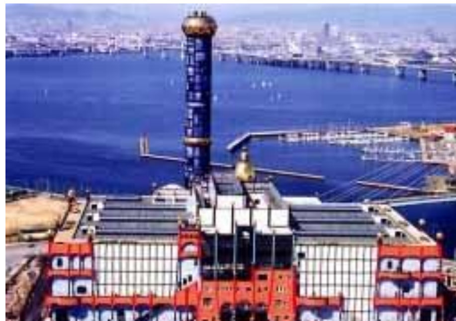
■舞洲スラッジセンター外観
