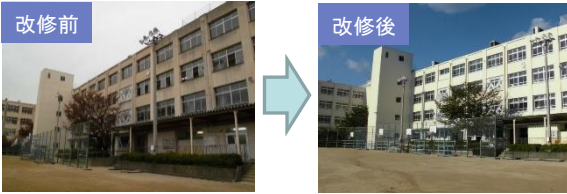
長寿命化事例(外壁改修等)
