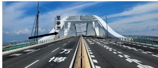
アクセスルートの整備 区画線補修イメージ
