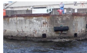
劣化が進行している係留施設(岸壁、物揚場)等の補修 市民利用施設等の緊急的な安全対策
