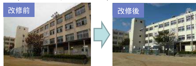
長寿命化事例(外壁改修等)
