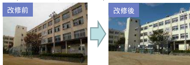
長寿命化事例(外壁改修等)
