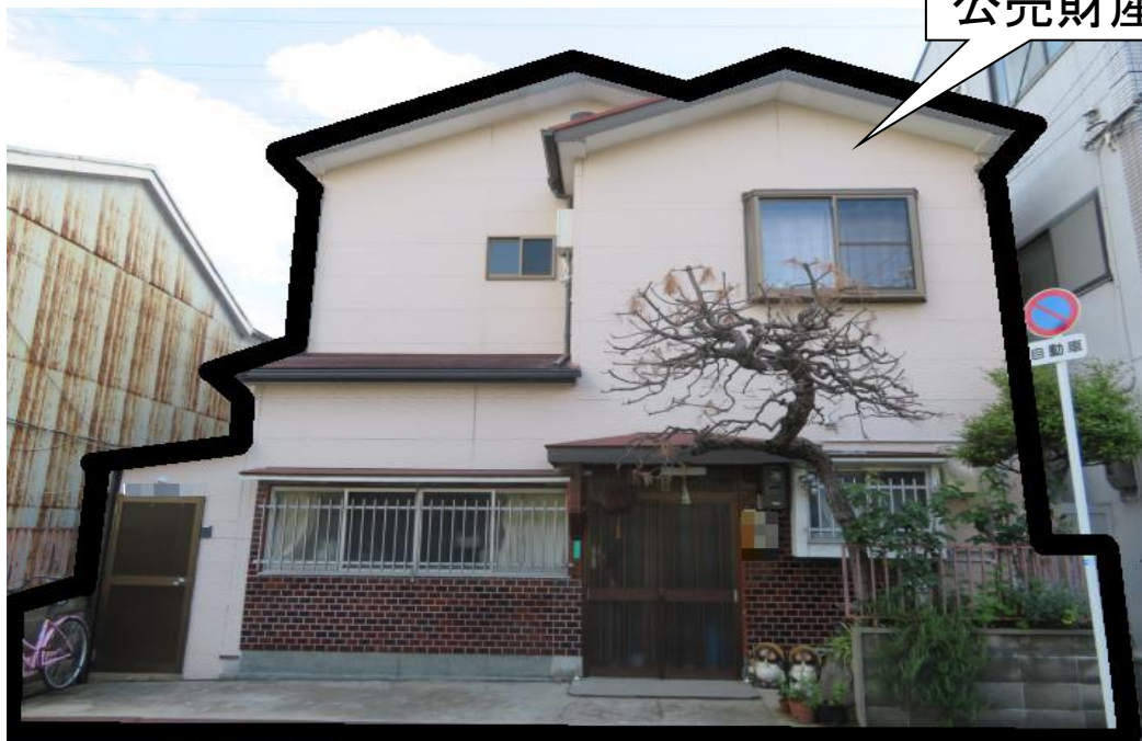
外観（北側から撮影）
