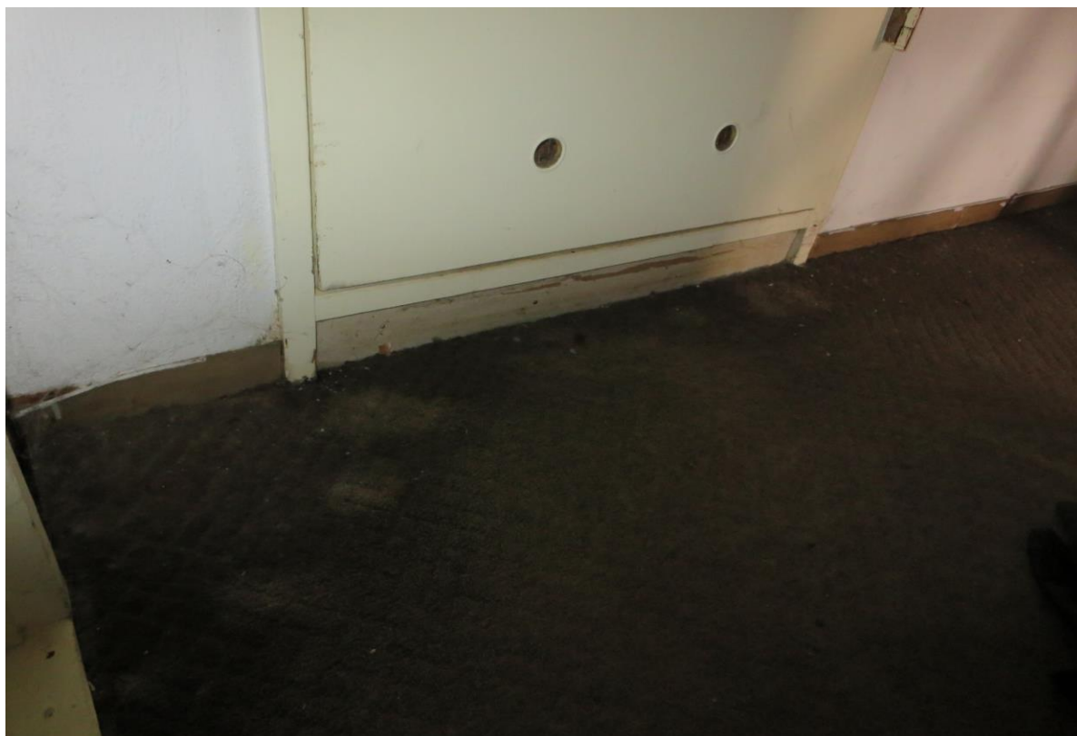
⑪便所入口付近の床
