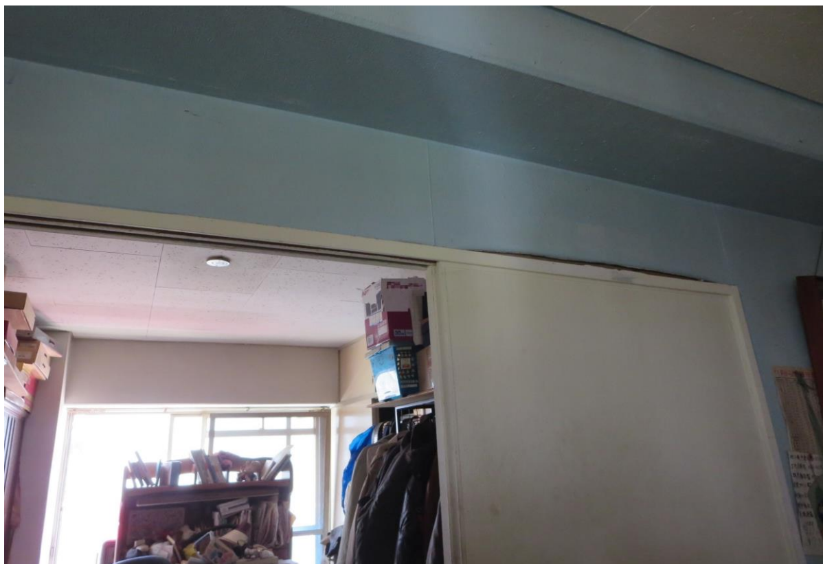
⑫北東角洋室入口上部
