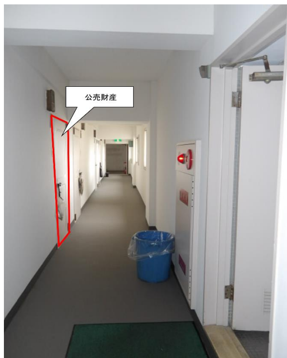
玄関前通路（共用部分） 南側から撮影
