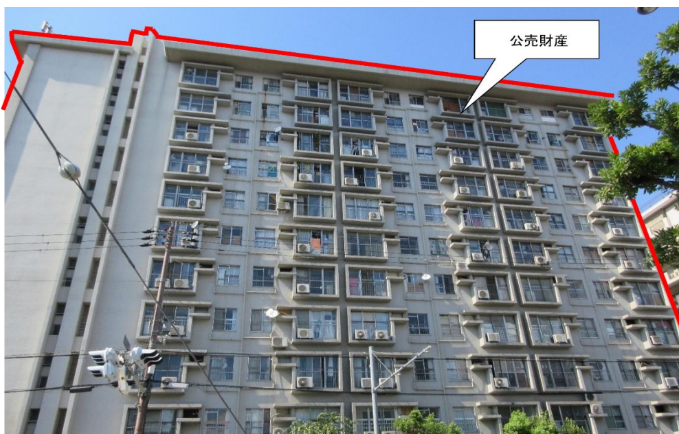
外観（南側から撮影）
