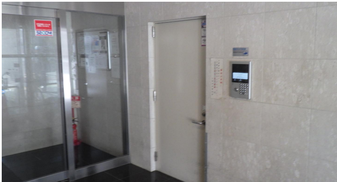
エントランスホール(共用部分)
