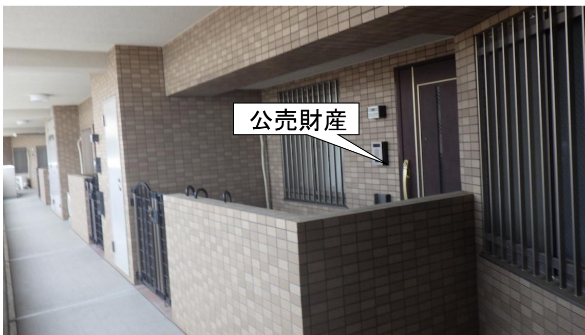
部屋前廊下(共用部)
